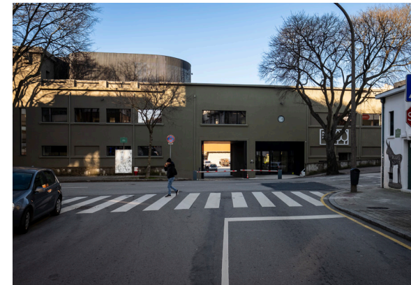
Edifício S. Dinis
