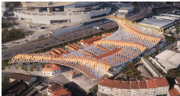
Reconversão do Antigo Matadouro Industrial do Porto
